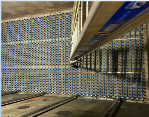
Renouvellement d'un biofiltre
