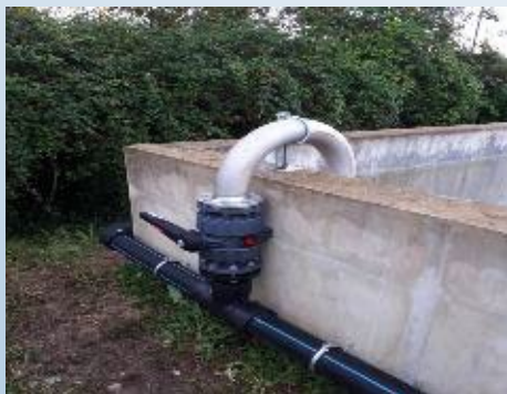
Rampe de lavage Bassin d'Orage STEP de Châteauneuf-Grasse
