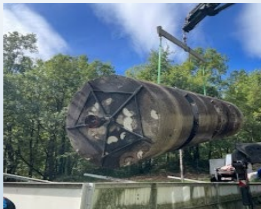
Renouvellement partiel des Biodisques STEP de Gréolières Village
