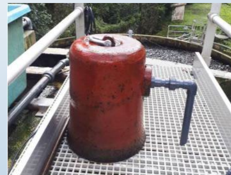
Cloche gravitaire de recirculation STEP de Tourrettes-sur-loup
