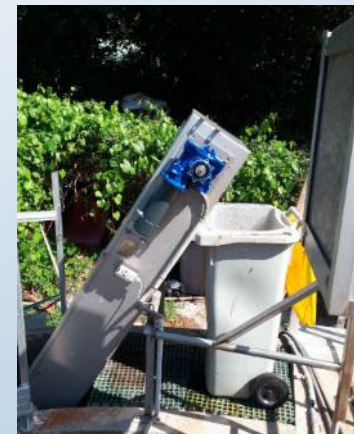
Rénovation dégrilleur STEP de Coursegoules
