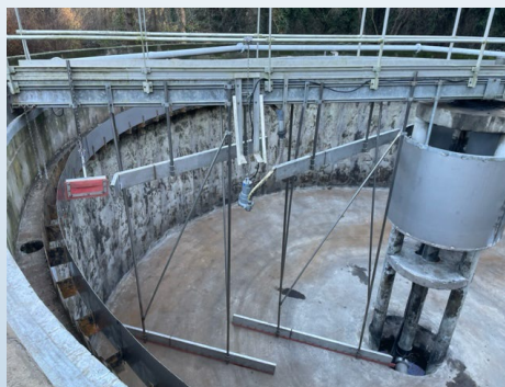
Rénovation du clarificateur STEP du Bar-sur-Loup
